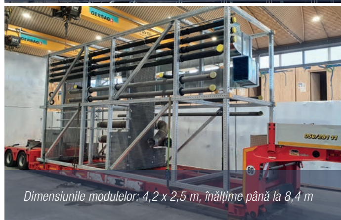
Modulele au fost introduse în clădire cu ajutorul unei macarale prin deschiderile pentru construcție.
