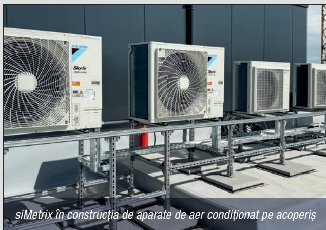
siMetrix în conexiune directă cu grinda de oțel
