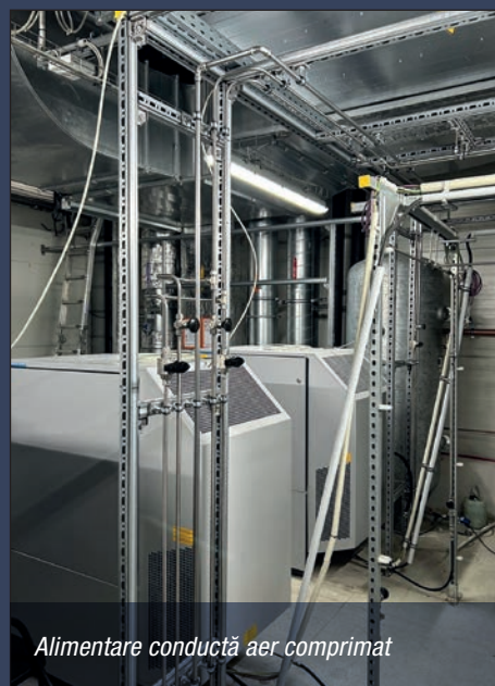
Îmbinare stabilă pentru conectarea coloanelor de medii. În combinație cu unitatea de nivelare, aceasta garantează poziția corectă a profilului de laborator și a coloanei de medii.
